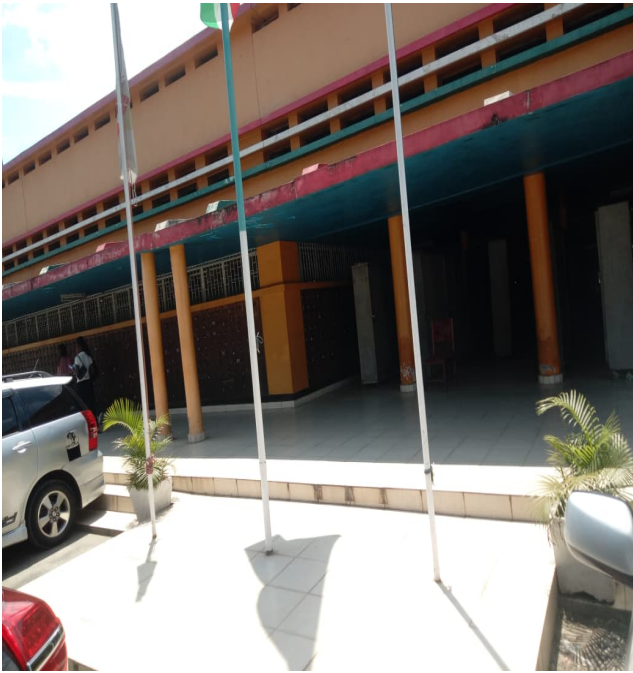
Aménagement extérieur et mâ de drapeau
