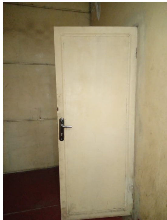
Remplacement des serrures
