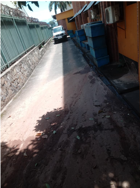
Aménagement de la cour intérieure
