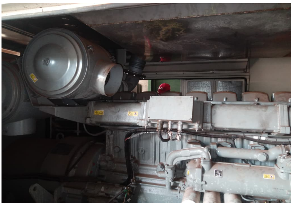
Filtre du groupe électrogène
